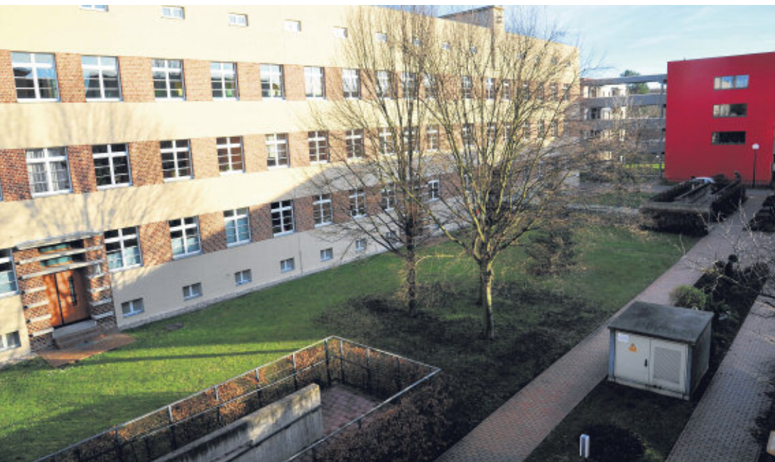
Blick auf einen Teil der heutigen Anlage des Seniorenheims „Riedelstift“ im Eigentum des Arbeiter-Samariter-Bundes. Hier ist Platz für 83 Menschen, darunter in 45 Wohnungen für betreutes Wohnen. Mit Stolz verweist der ASB auf das Gründungsjahr 1897 Fotos: J. Heinrich
